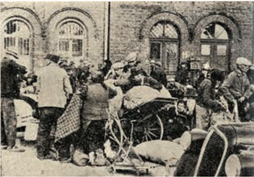
← Oleśnica, 1945. Grupa szabrowników przed budynkiem dworca
